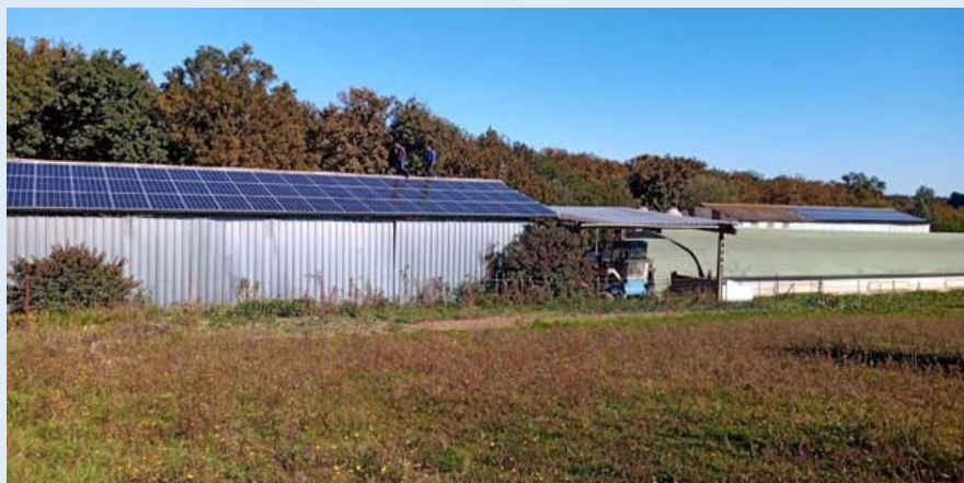
36 kWc Hangars à Espanès, Mis en service décembre 2021
