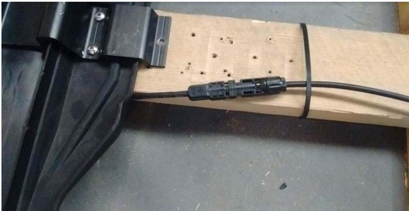
Figure 24 – Cheminement des câbles sous les cadres polymère et leur fixation par collier de câblage
