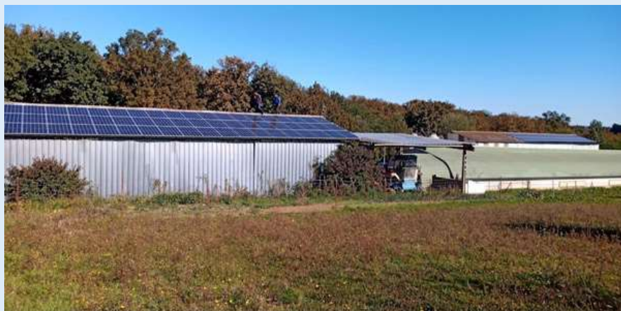
36 kWc Hangars à Espanès, Mise en service décembre 2021
